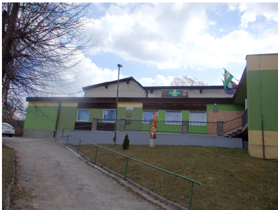
Obrázok 2: Severný pohľad na budovu
