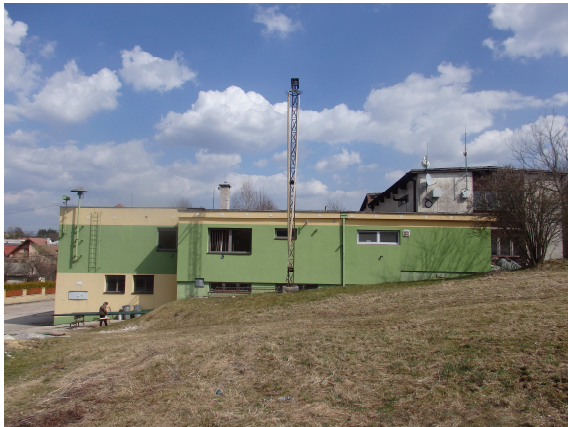
Obrázok 3: Západný pohľad na budovu
